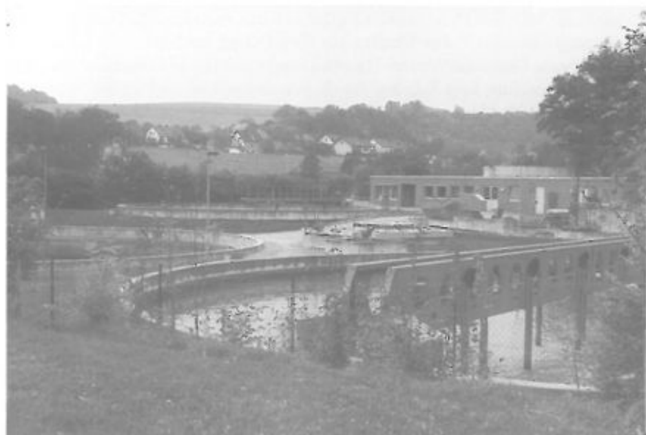
Die Gruppenkläranlage in der Verbandsgemeinde Rhauen am tiefsten Punkt in der Gemarkung Hausen.
