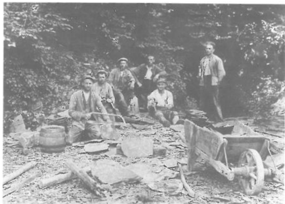
Layenbrecher vor der Schiefergrube "Morgensonne" zwischen Hausen und Oberkirn. Vor dem Schiefer-spalten mußten die Schieferblöcke "geköpft" werden, d. h. es wurde ein Keilstück aus dem Block gesägt, mit einem Schlag auf einen darin passenden Eisenkeil entgegen der Schieferung geteilt, um dann Schieferplatten der gewünschten Größe spalten zu können (Zweiter v. l. Jakob Kappel aus Hausen).
