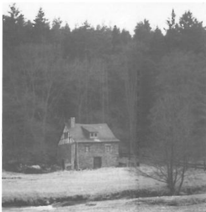
Die Hausener Bauernmühle, um 1980.
