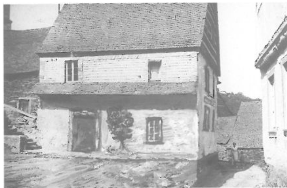
Haus Hauptstraße 31, Hausname "Wierts". Aufnahme um 1940; Retusche von R.A.A.
