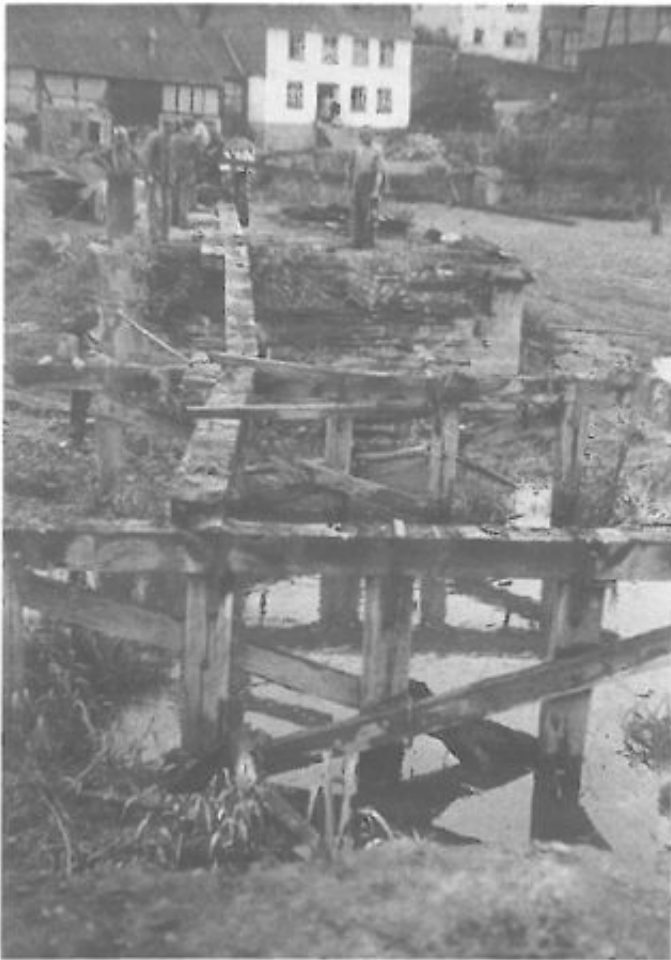
Abbruch der alten Brücke über den Kyrbach in der Dorfmitte, die 1875 erbaut wurde. Für die Konstruktion aus Eichenpfeilern (die meisten davon 30 cm im Quadrat) soll das "Lückerswäldchen" abgeholzt worden sein. Die neue Betonbrücke wurde 1956 erbaut.
